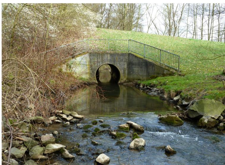
**Abb. 28:** Damm und Drosselorgan des Hochwasserrückhaltebeckens am Wannebach (km 1,5)
