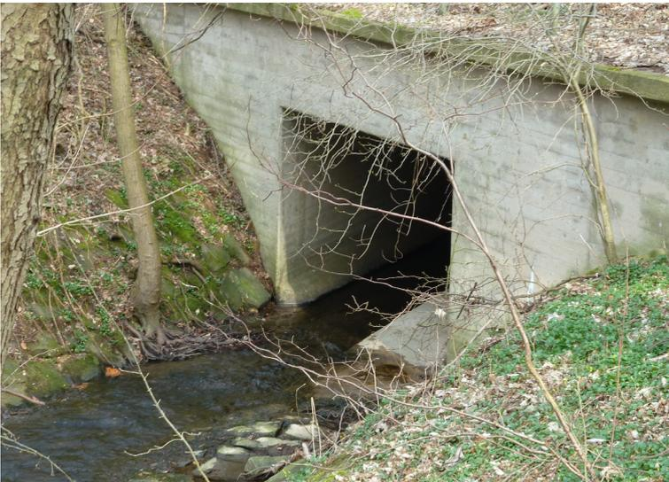
**Abb. 24:** Nicht durchgängiger Durchlass des Pleßbaches unter der Autobahn A 43 bei km 8,5
