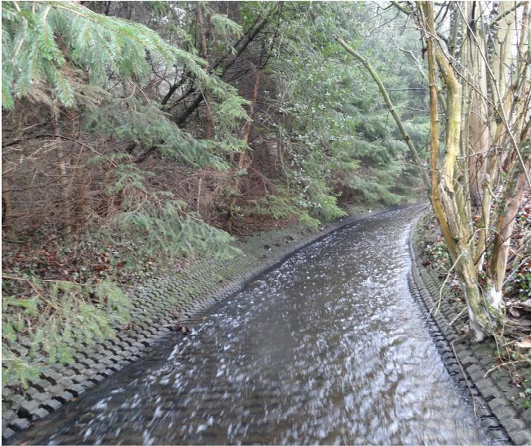
**Abb. 18:** *Sohl- und Uferverbau am Hesperbach (km 2,46)*
