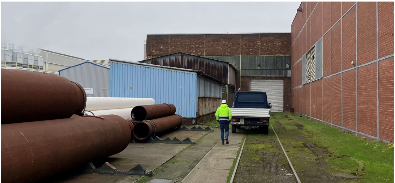
Abbildung 5-1: Nordseite von Gebäude 620
