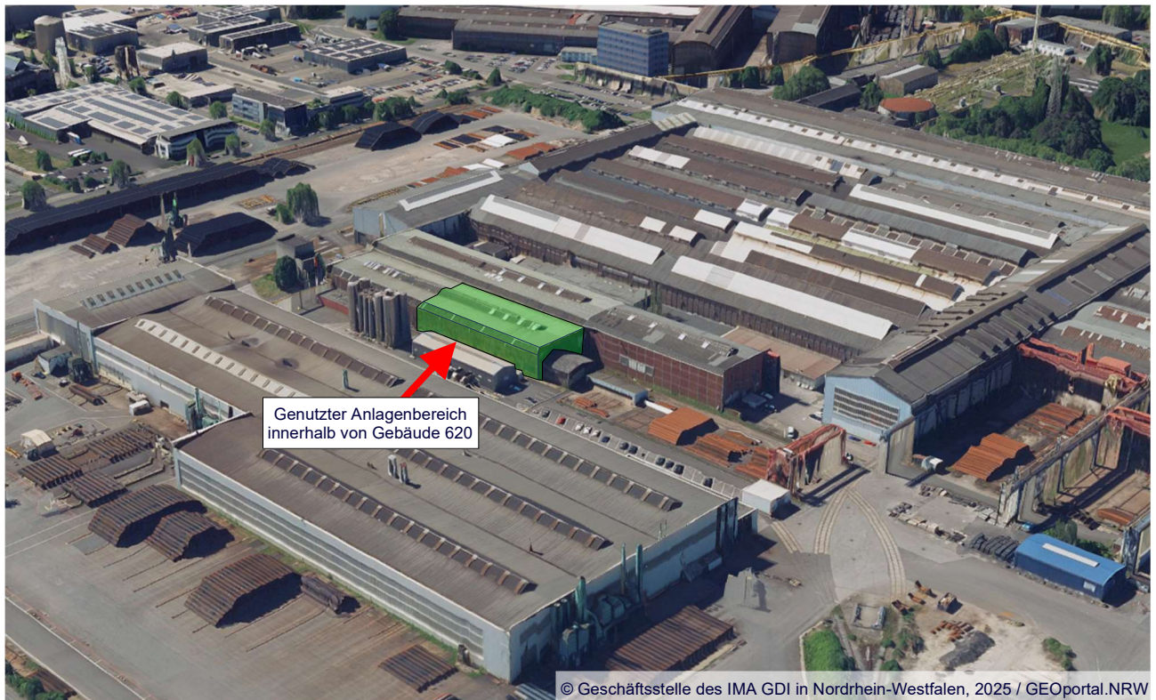
Abbildung 4-3: Gebäudesituation um die geplante Beschichtungsanlage – Blick aus Norden
