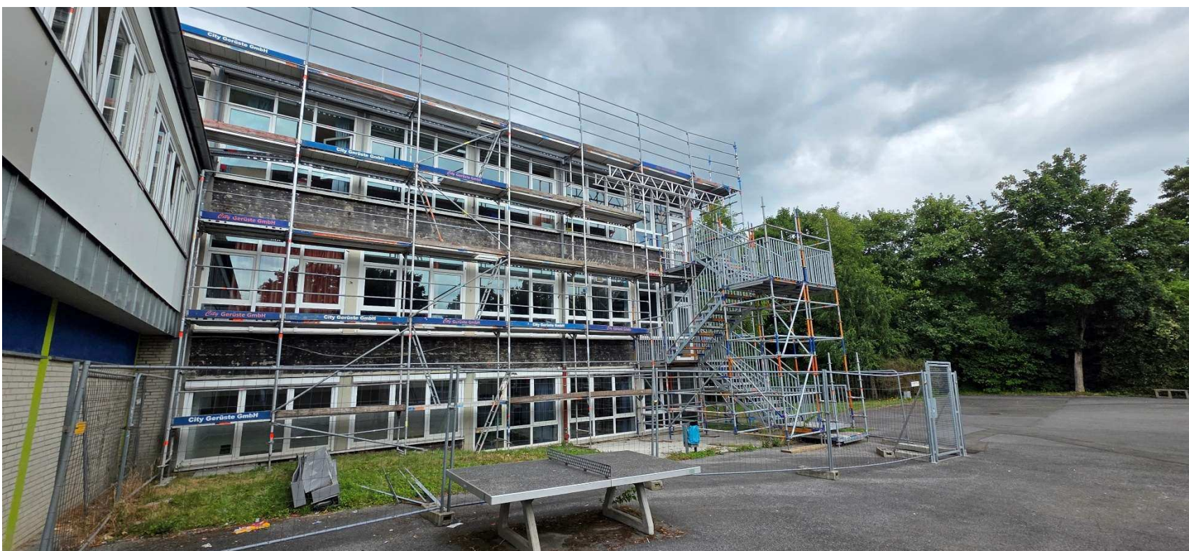
Abbruch Verblender-Fassade / Interimstreppenturm
