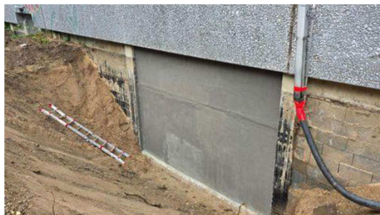
Abdichtung und anschließende Dämmung der einzelnen Felder
