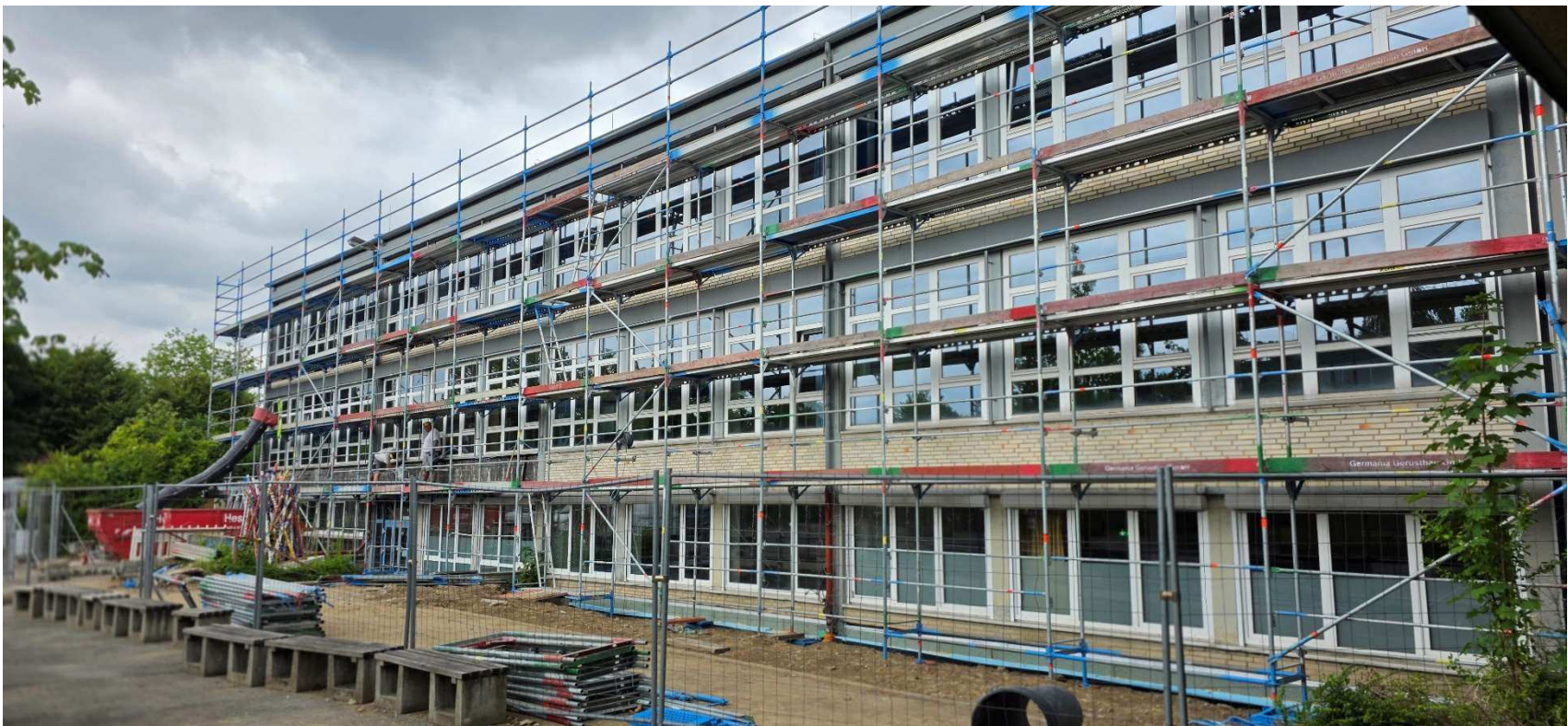
Einrüstung Südseite vor Austausch der Fenster
