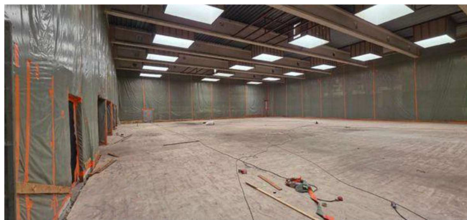
Innenansicht der Sporthalle nach den Abbrucharbeiten, während der Schadstoffsanierung
