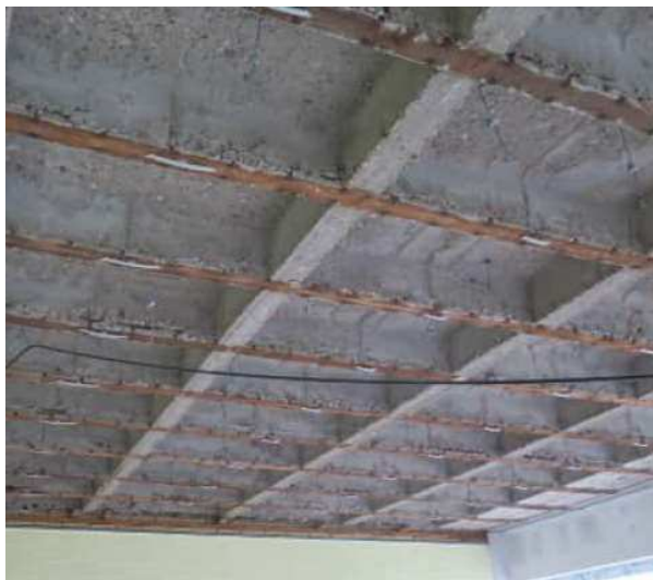
Abb. 3: Rippendecke vor der Sanierung
