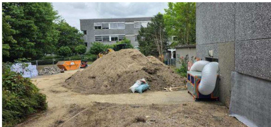
Erdarbeiten mit Entlüftung des Innenraums während der Schadstoffsanierung
