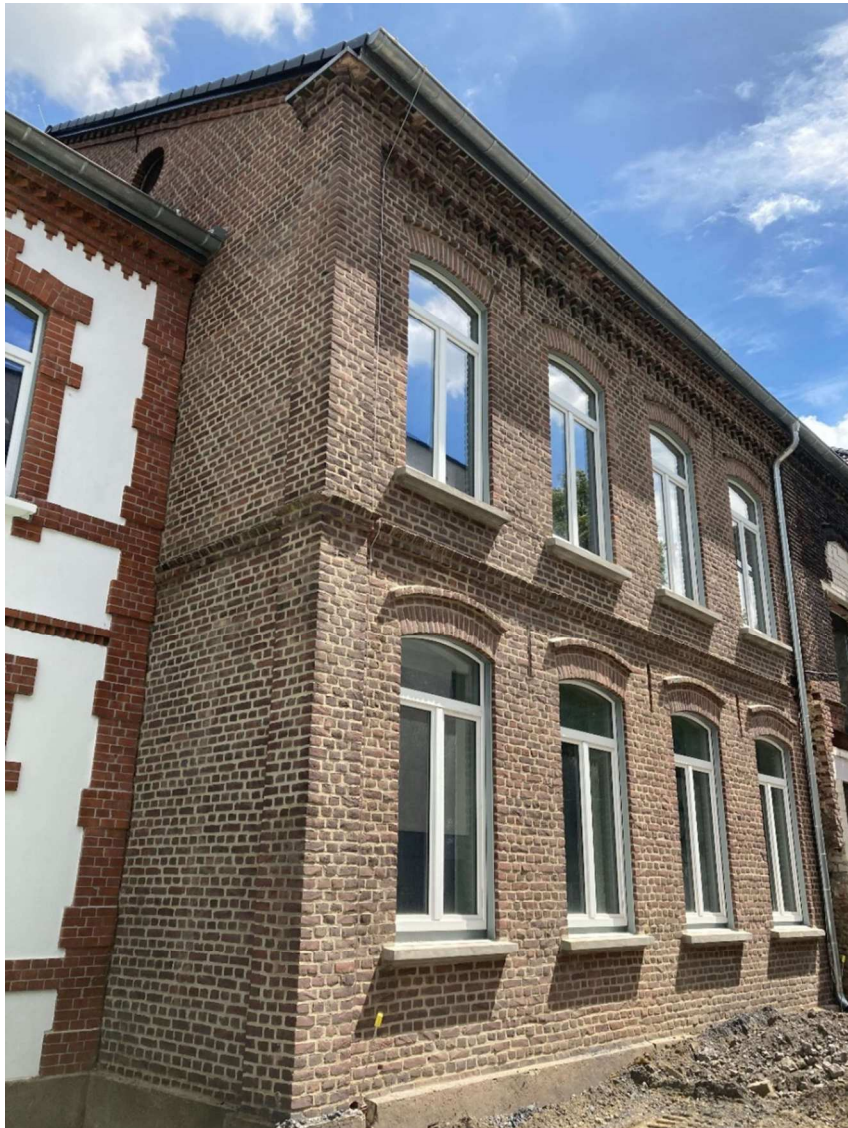
Sanierte Bauteile von 1899/1944 Süd-West
