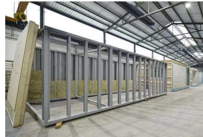
Stahlkonstruktion eines Modules
