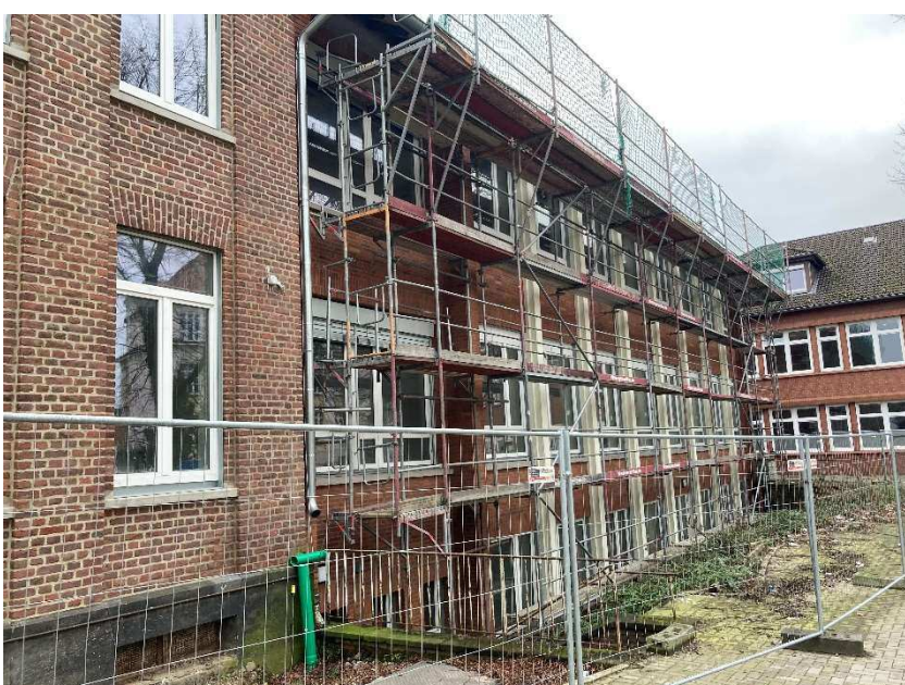
GGs Augustastraße/Hauptgebäude Sanierung
