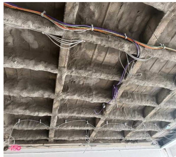
Abb. 4: Rippendecke nach der Sanierung
