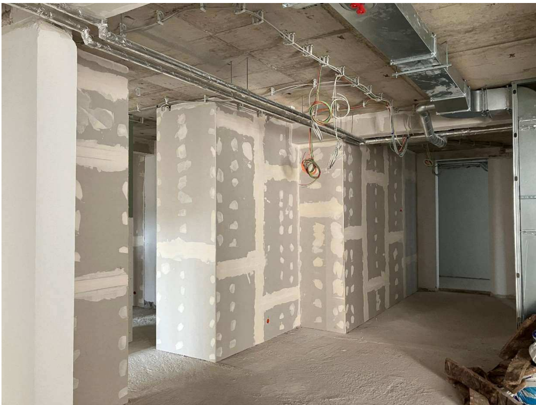
Neue Trockenbauwände und Lüftungskanäle
