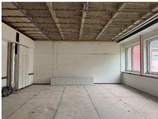
Abb. 5: Klassenraum vor der Sanierung
