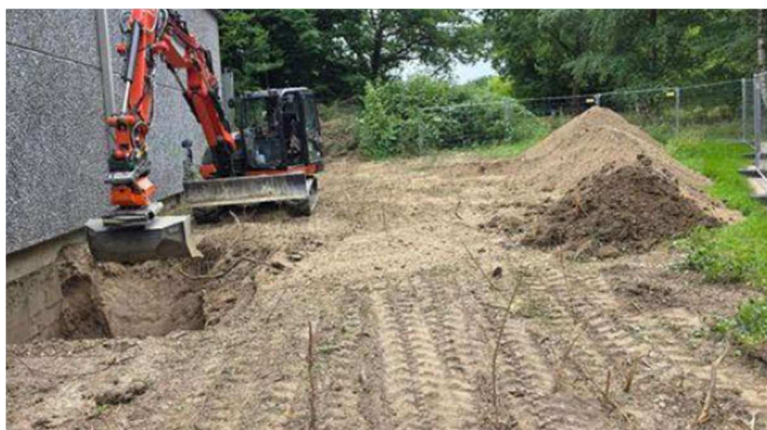
Bodenaushub an der Außenwand-Südseite. - Aus statischen Gründen ist der Aushub nur abschnittsweise möglich.
