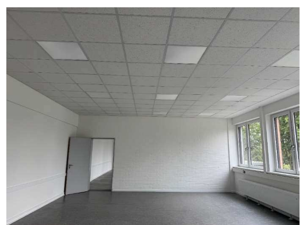
Abb. 6: Klassenraum nach der Sanierung
