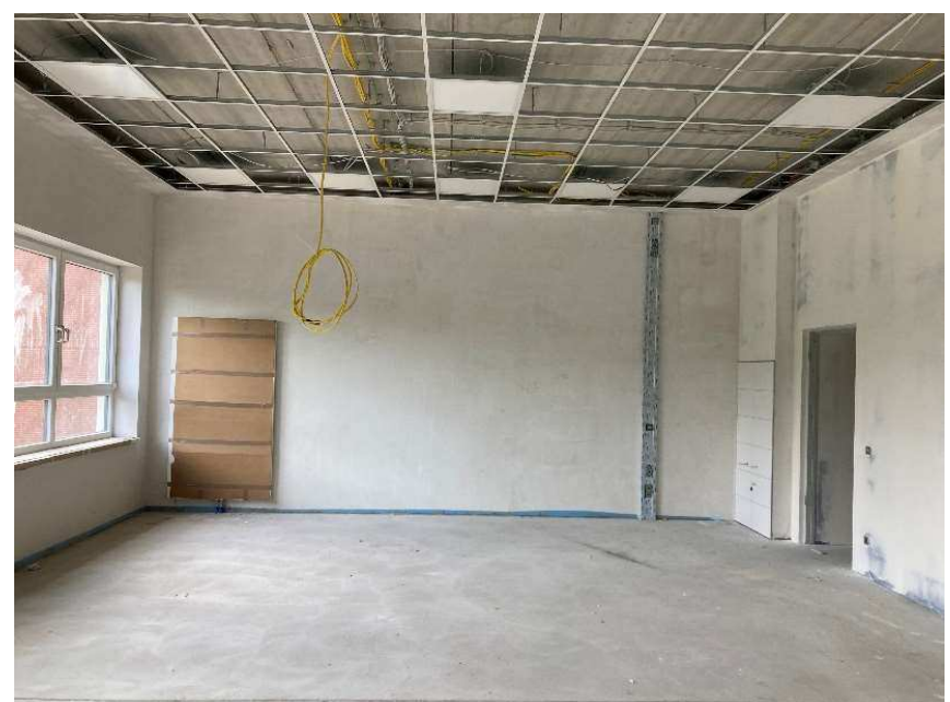
Unterrichtsraum im Erweiterungsbau
