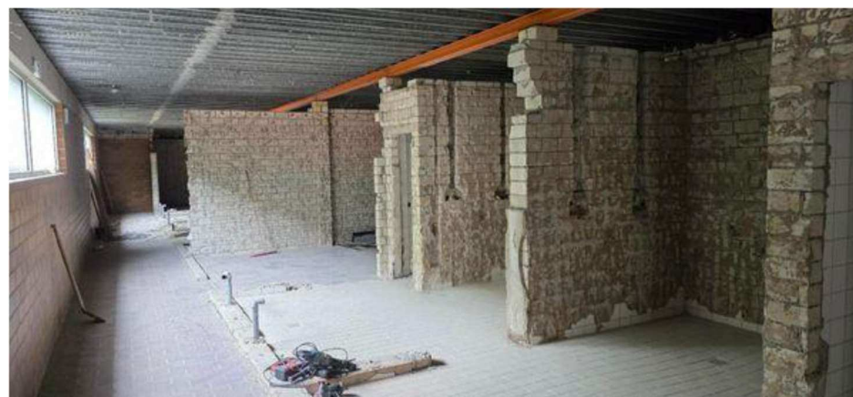
Innenansicht des Sanitär- und Umkleidetraktes während der Abbrucharbeiten
