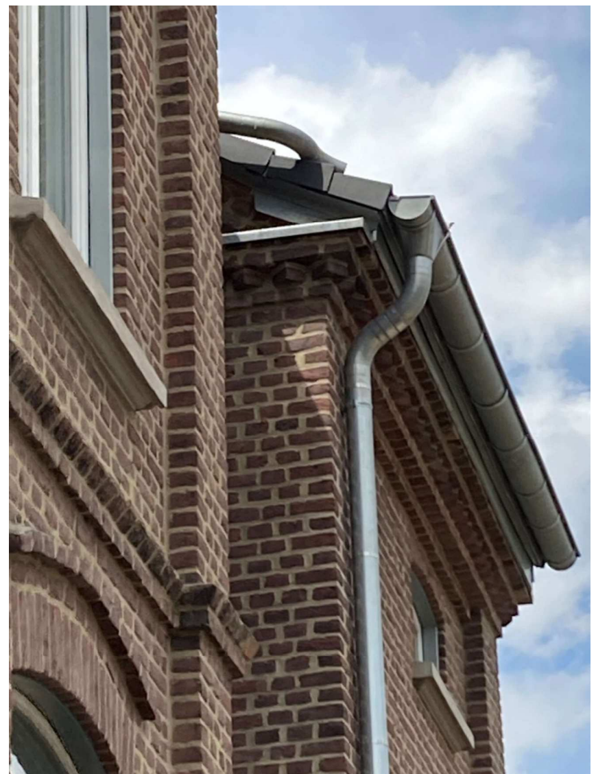
Detail Fassadensanierung Nord-Ost
