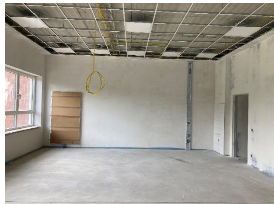
Unterrichtsraum im Erweiterungsanbau
