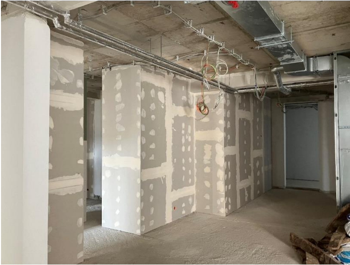
Neue Trockenbauwände und Lüftungskanäle
