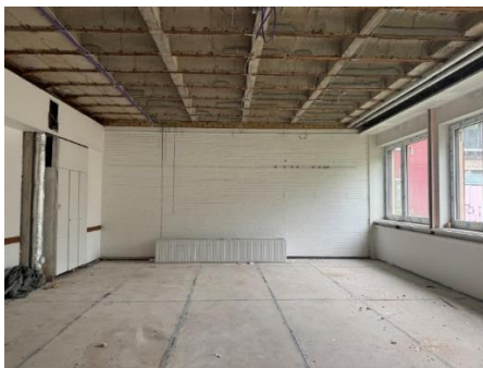
Abb. 3: Klassenraum vor der Sanierung
