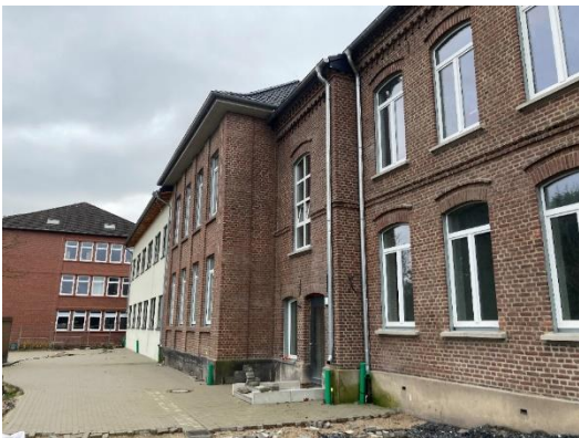
Erweiterungsanbau GGS (WDVS-Fassade)
