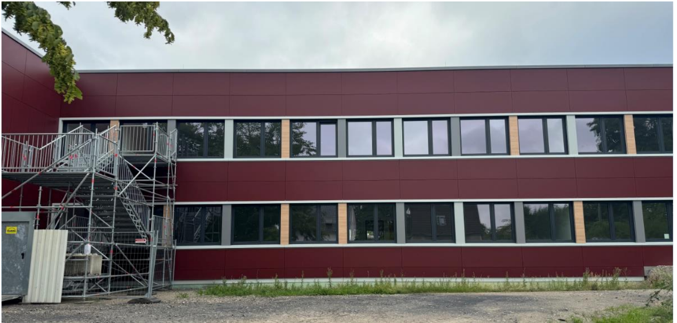
Abb. 7: Südfassade – Vorgezogene Maßnahme
