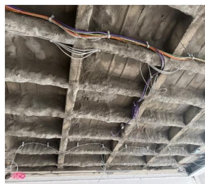
Abb. 6: Rippendecke nach der Sanierung
