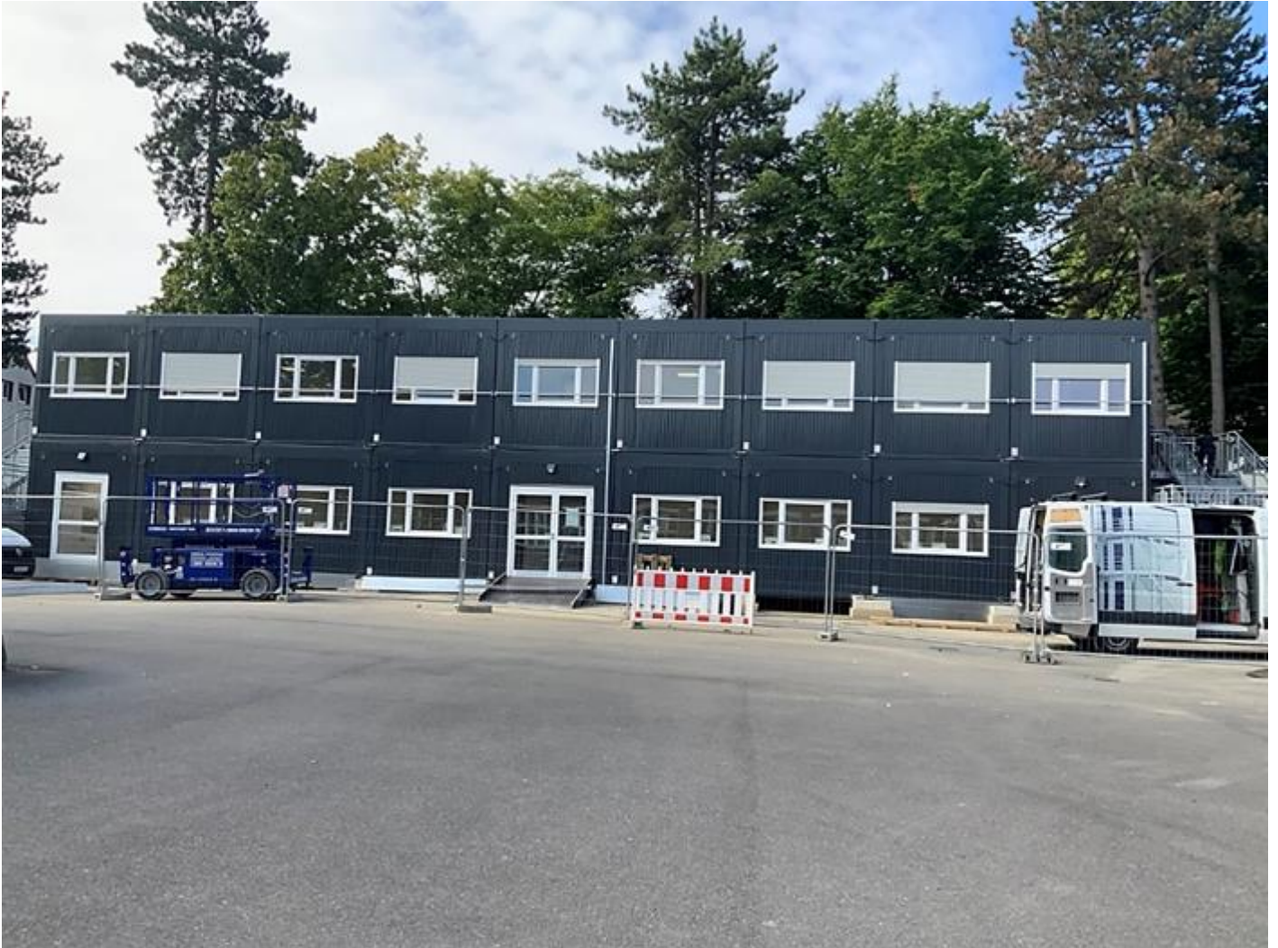
Montage Pavillonanlage Luisenschule, Stand Juli 2025
