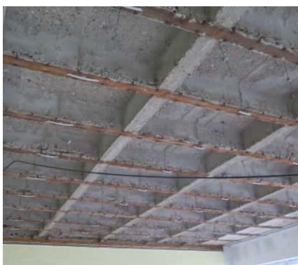
Abb. 5: Rippendecke vor der Sanierung
